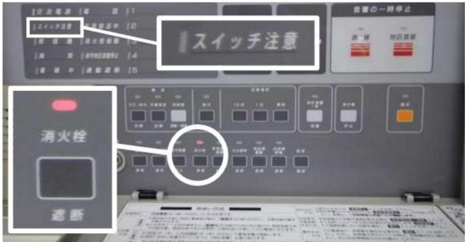
※ポンプが作動しないように「消火栓 遮断」を押しておく。「スイッチ注意」が点灯する。
