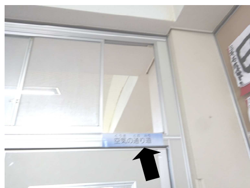
ろうかがわ まど 廊下側の窓
