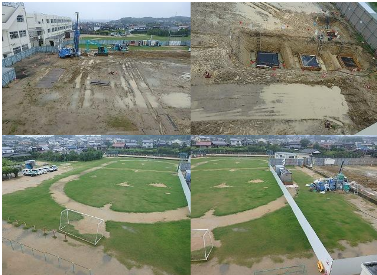
9月2日(月) 体育館工事・運動場の様子
