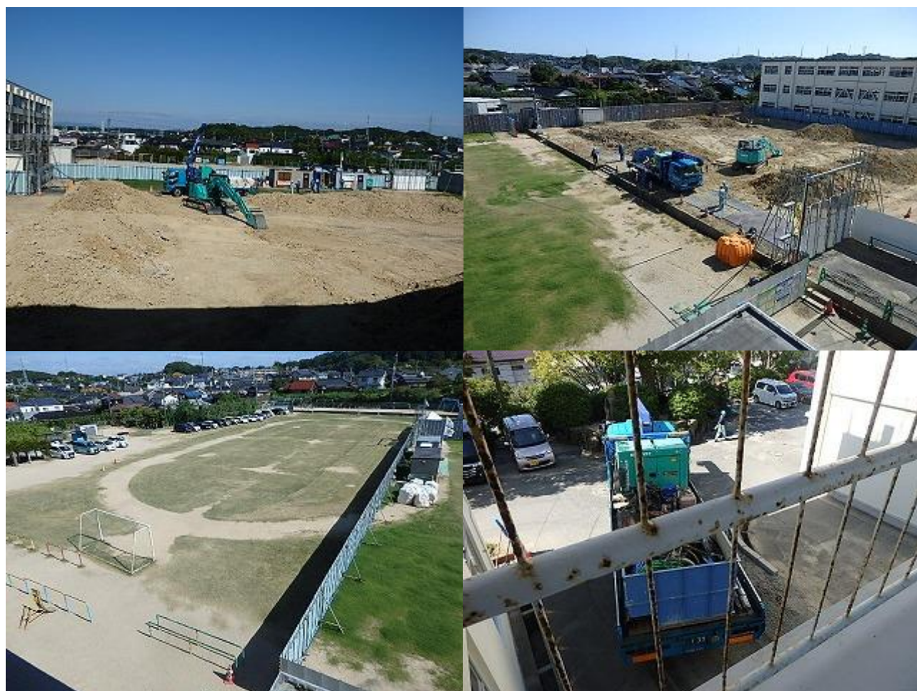
9月18日(水) 体育館工事・運動場の様子
