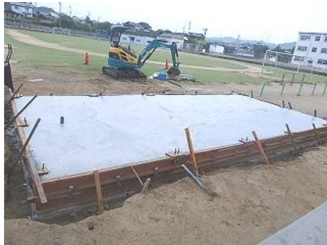
西校舎北側 仮設給食配膳室工事
