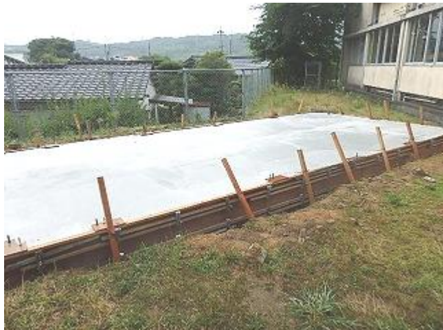
新館北側 仮設給食配膳室工事
