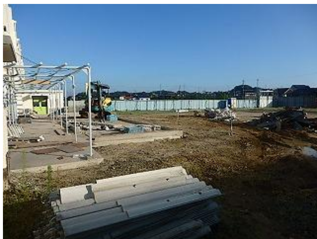
給食配膳室取り壊し 7月30日(火)
