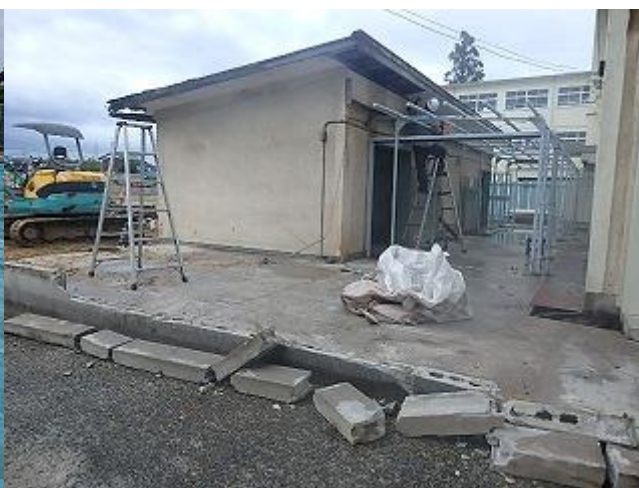
給食配膳室取り壊し 7月29日(月)
