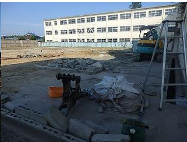
給食配膳室取り壊し 7月31日(水)
