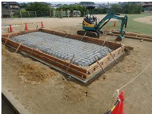
西校舎北側 仮設給食配膳室工事
