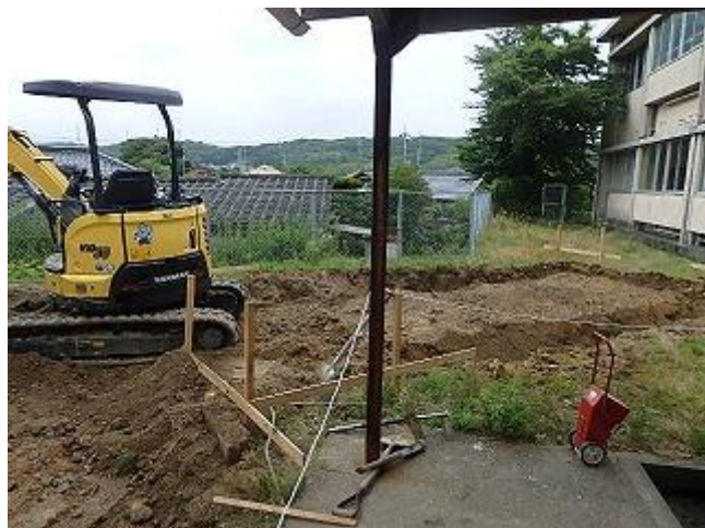
新館北側 仮設給食配膳室工事
