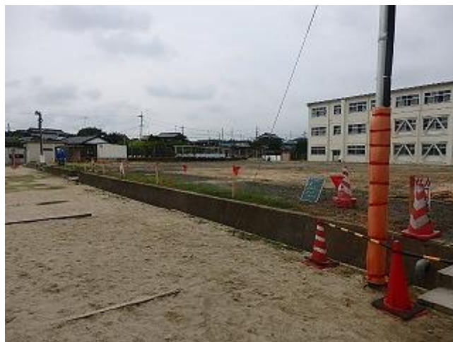
体育館工事 立ち入り禁止ロープ設置
