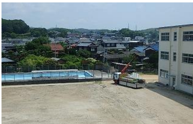
左) プール通路工事
