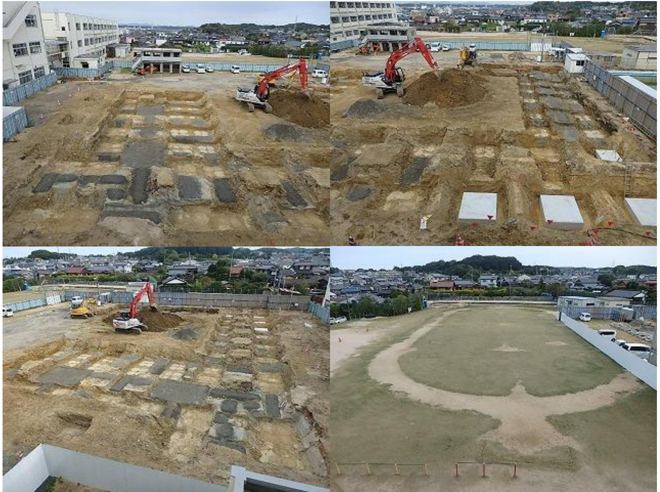
今週の体育館工事 ・ 運動場
